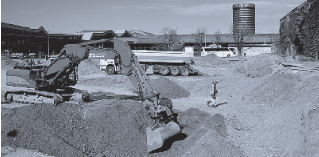
Die stets sich weiter entwickelte Mechanisierung auf den Baustellen führt zu noch leistungsfähigeren und komfortableren Baugeräten.
