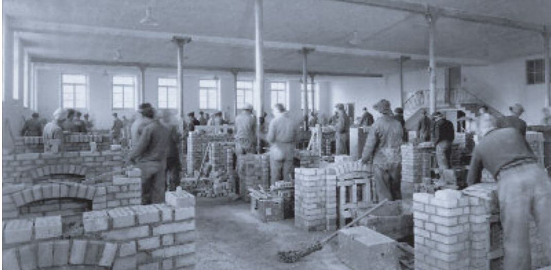
Ausbildungszentrum der Bauarbeiter in Wetzikon – Übungsanlage für Maurer
